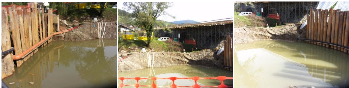
Izkopna jama ZB2
